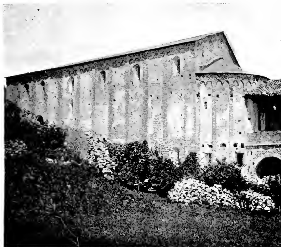
Fig. 369 — Esterno della chiesa di San Pietro al Monte di Civate (sec. IX)
